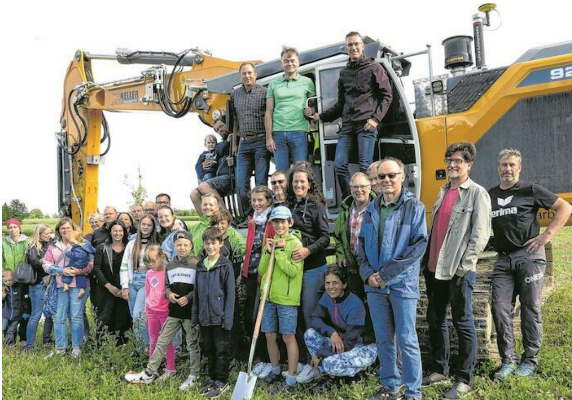
Baubeginn für den Bike-Park Pappelau-Beiningen. Foto: Margot Autenrieth
